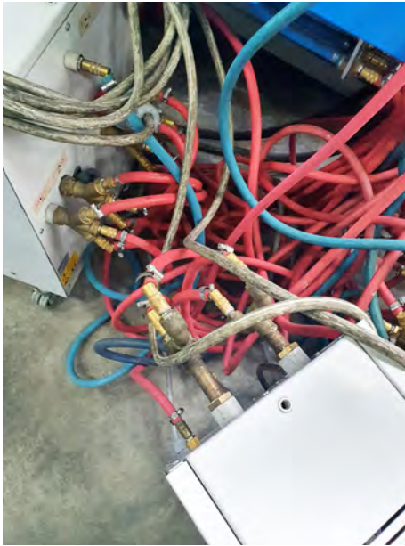
Vorher: Mehrere Temperiergeräte pro Kühlkreis, unübersichtlich organisierte Verschlauchungen, höhere Investitionen, höhere Wartungskosten, höherer Energieeinsatz.
